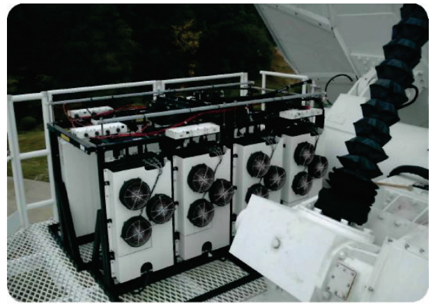
Рис. 10- 2.5kW усилительная система SapphireBlu™ на базе GaN-модулей Ku-диапазона
