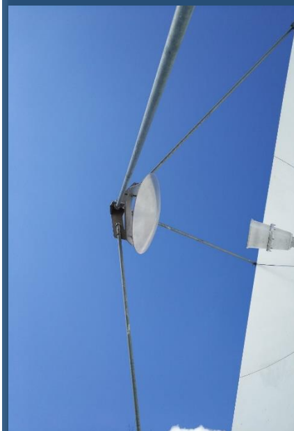
Цельнофрезерованный Контррефлектор антенны ТЛС-КМА-7.5-С (CIR-4P)
